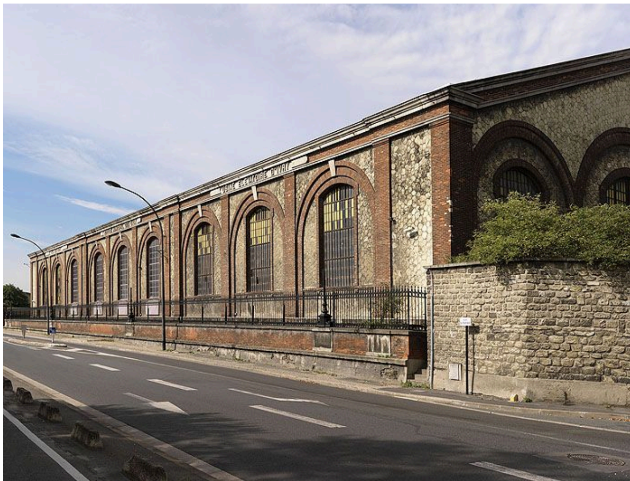
94, Ivry-sur-Seine, station de pompage Usine élévatrice des eaux de Paris, 1 rue Jean-Mazet. Façade longitudinale de l'usine côté Seine.
