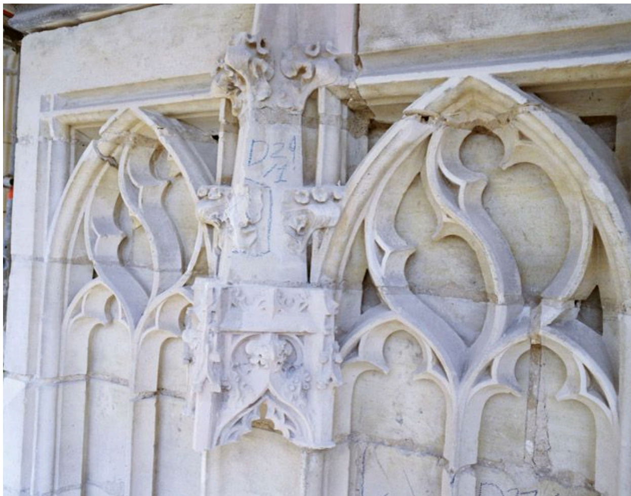
La façade occidentale : vue du chantier de restauration de la base de la tour nord (2008). Détail de la restauration des remplages et d'un dais flamboyants.
