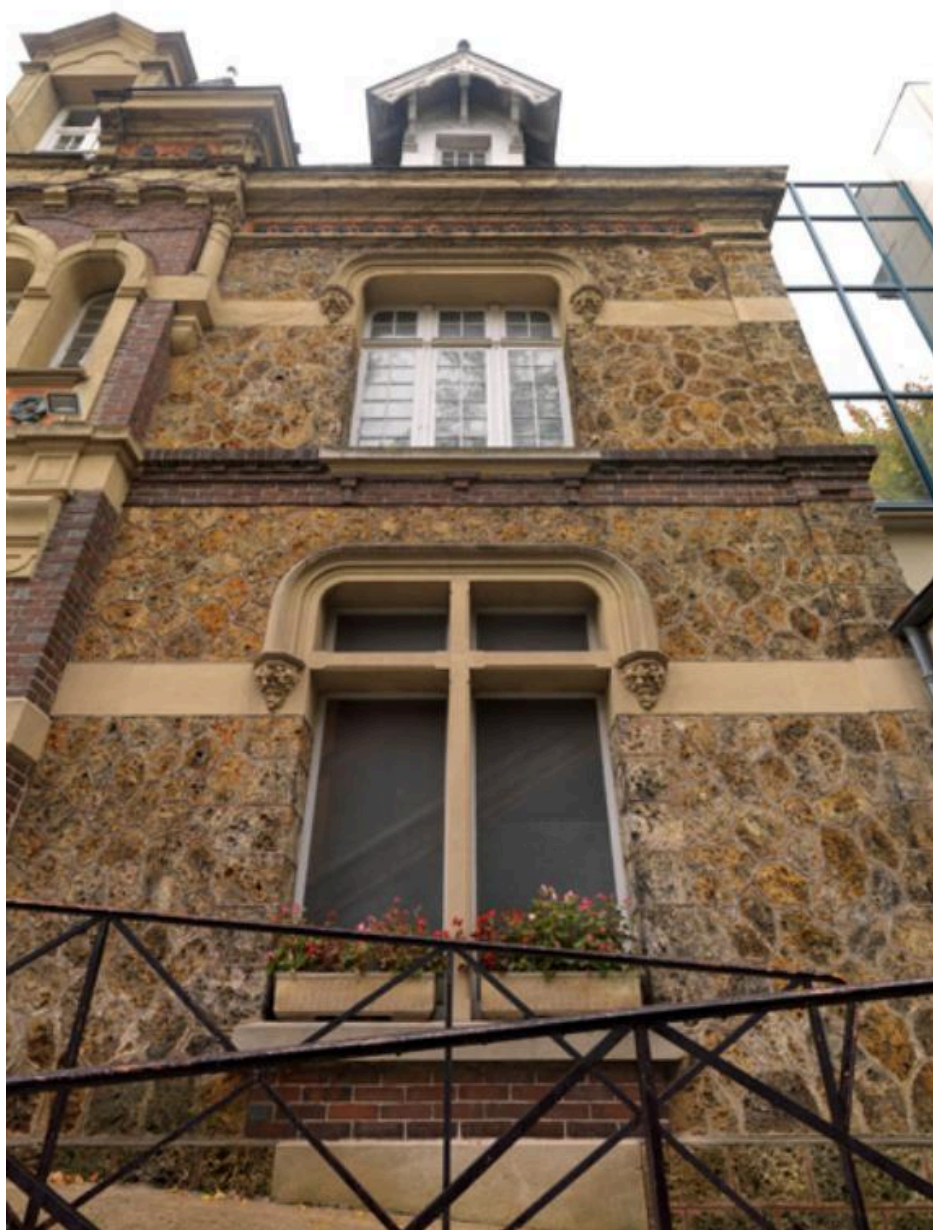
Une travée de la maison de notable , 23 avenue Duhamel, devenue polyclinique.
