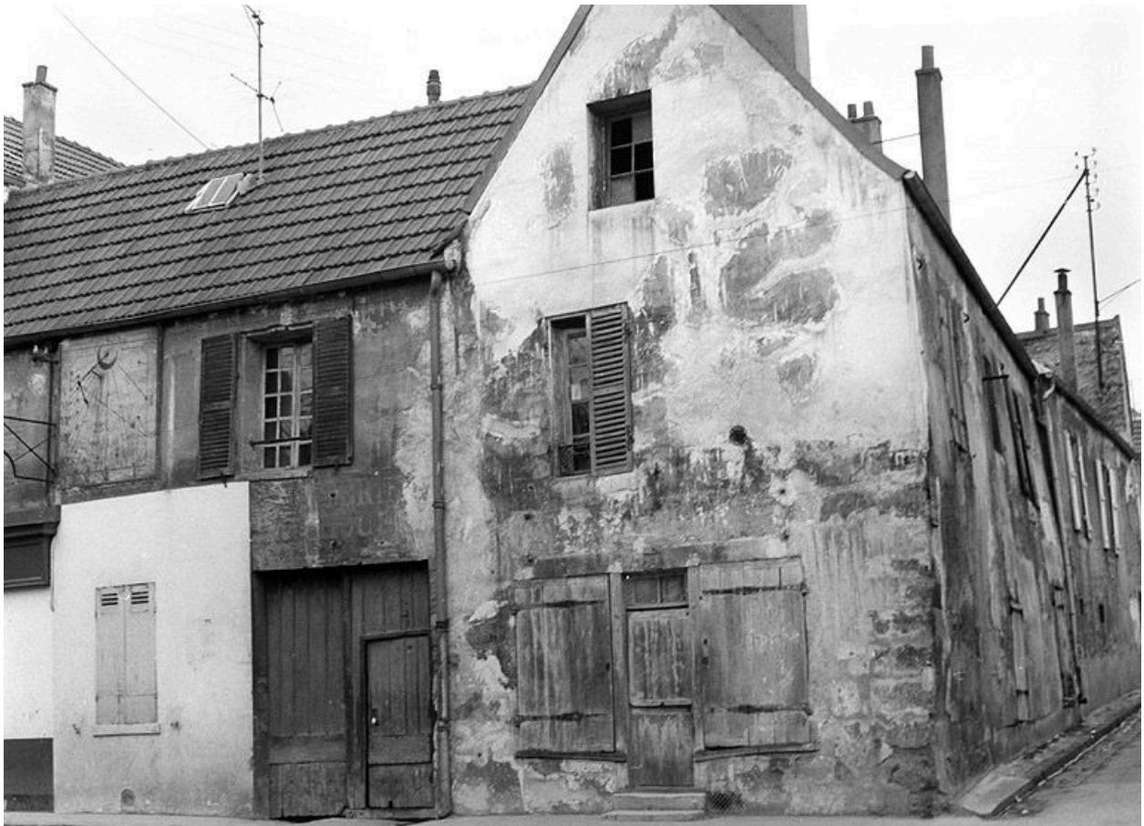
Andrézy. Maison de bourg avant transformation, 64 boulevard Noël-Marc : vue du bâtiment latéral droit. Photographie. (Région Ile-de-France, Service Patrimoines et inventaire, Cote Pré-Inventaire).
