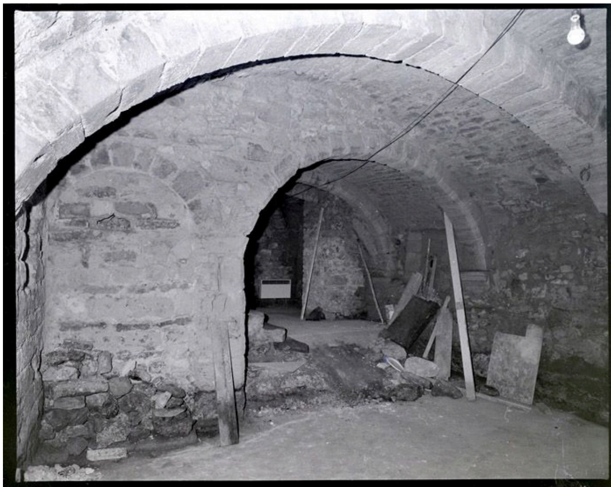
Maison, Chanzy (rue de) 1. Cave voûtée, vue d'ensemble.
