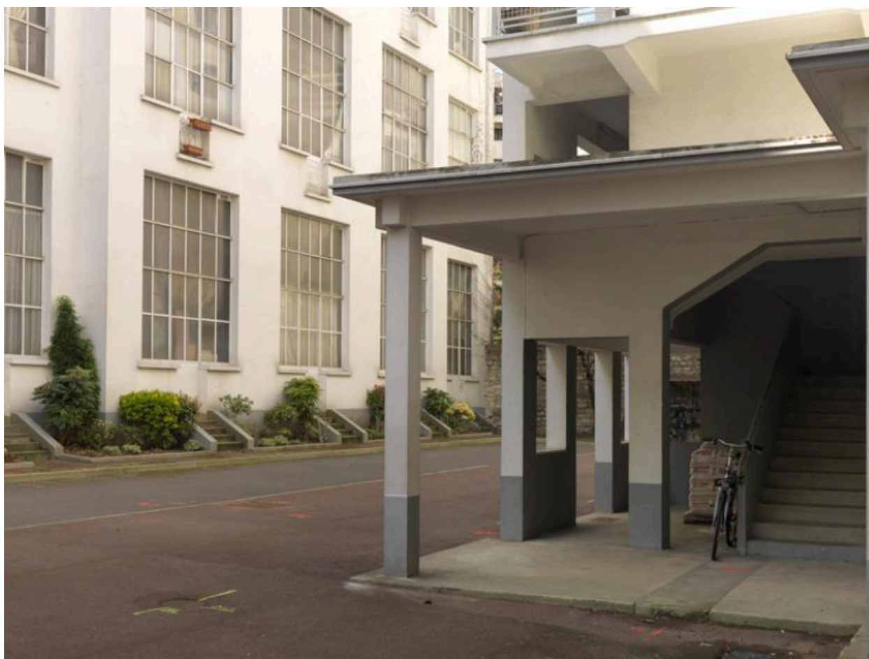
Vue des toits sur pilotis (côté droit)
