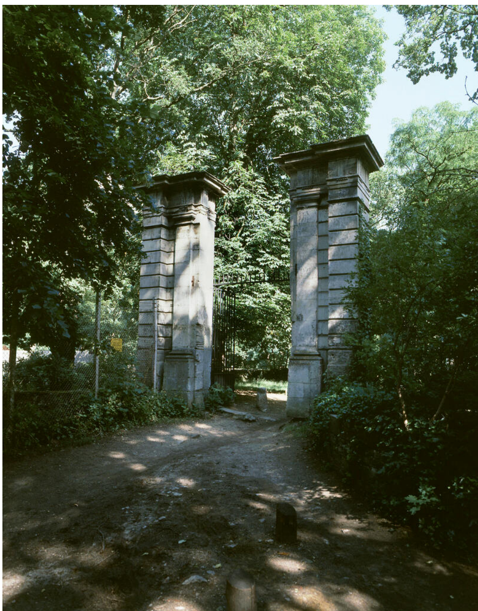
Entrée dite "les caves du Nord": détail de la porte vue depuis la forêt.
