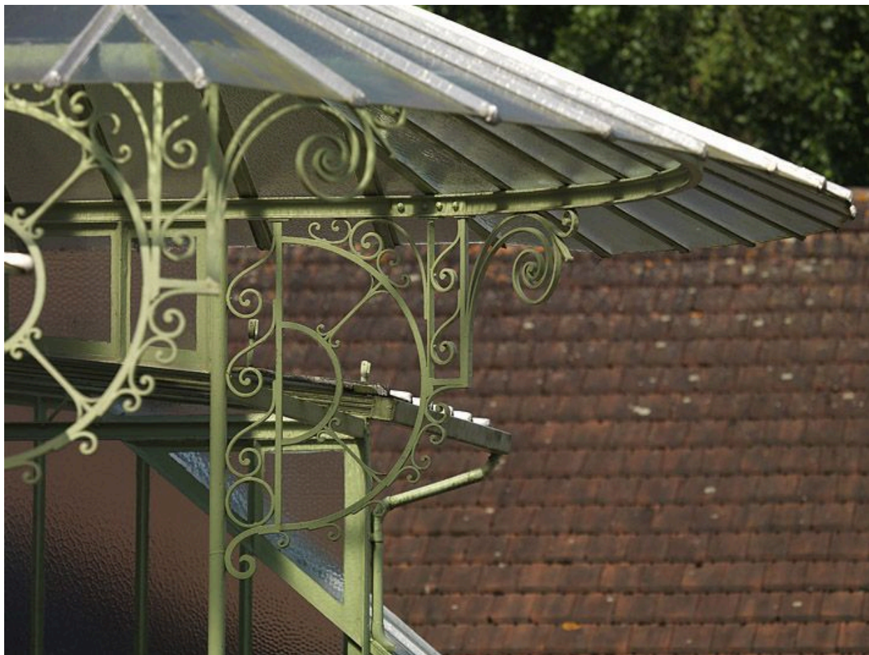
Marquise du logement patronal, décor de ferronnerie.
