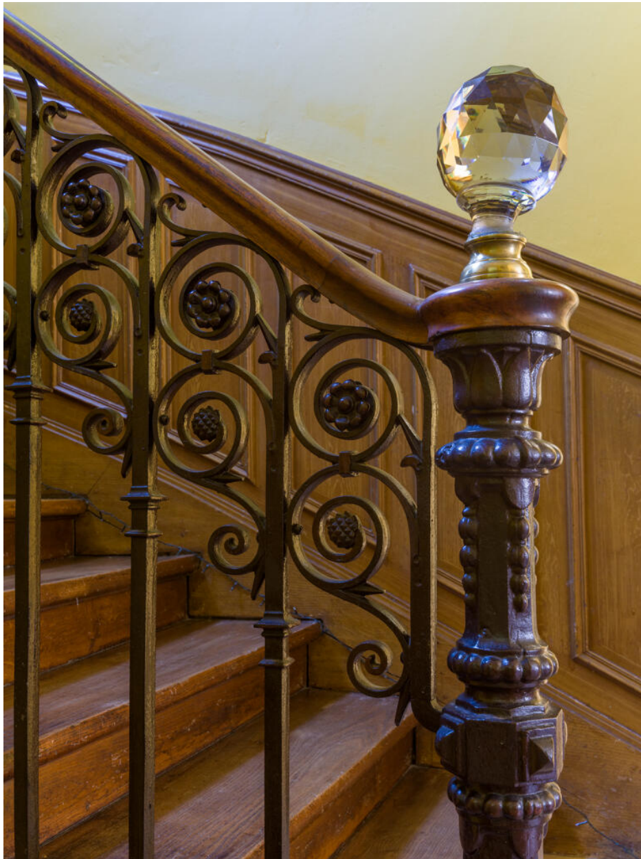
Détail du départ et de la rampe d'escalier.
