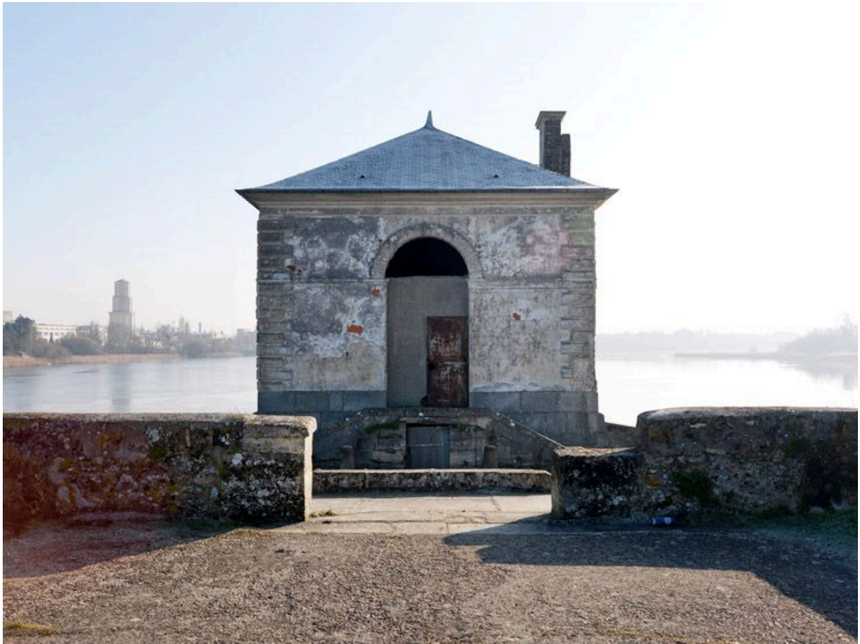
Saclay, route d'Orsay. Le pavillon du Roy sur la route d'Orsay.
