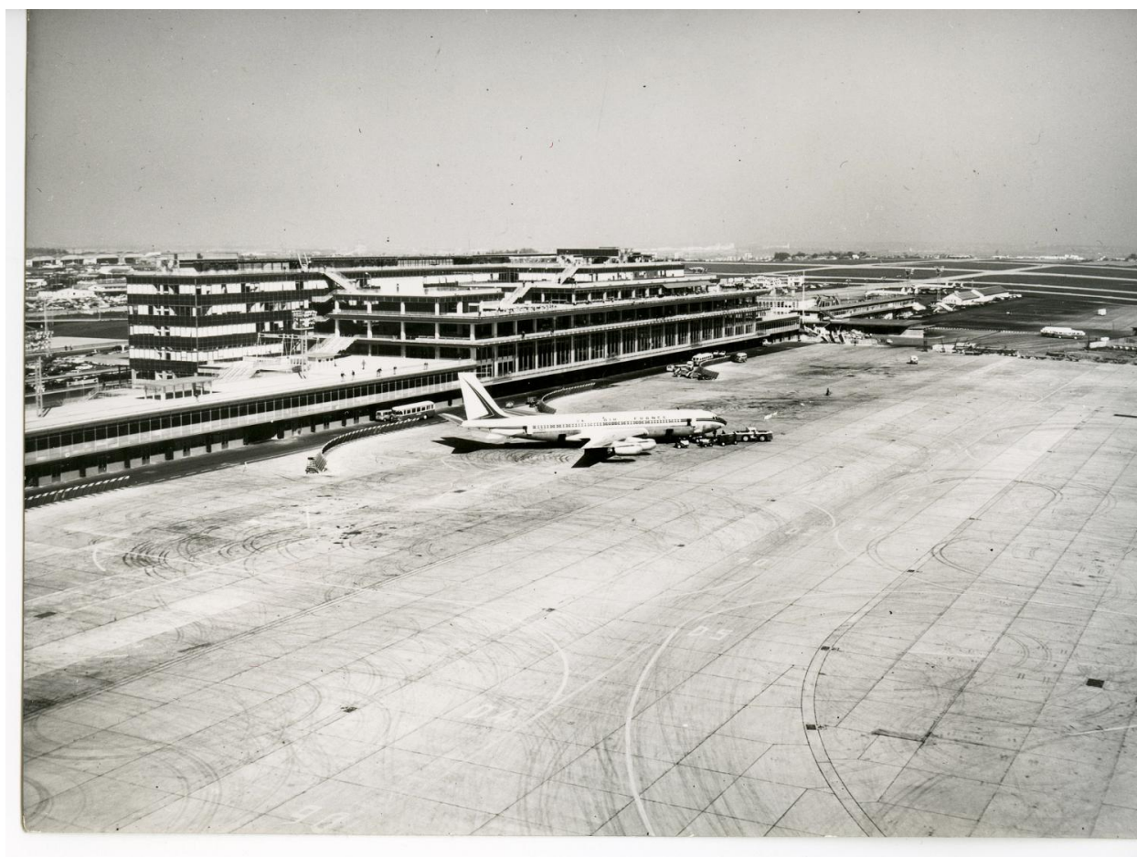
1961 février octobre, les travaux de jonction des Installations Terminales et de l'Aérogare-Sud, vus depuis le sud ouest.
