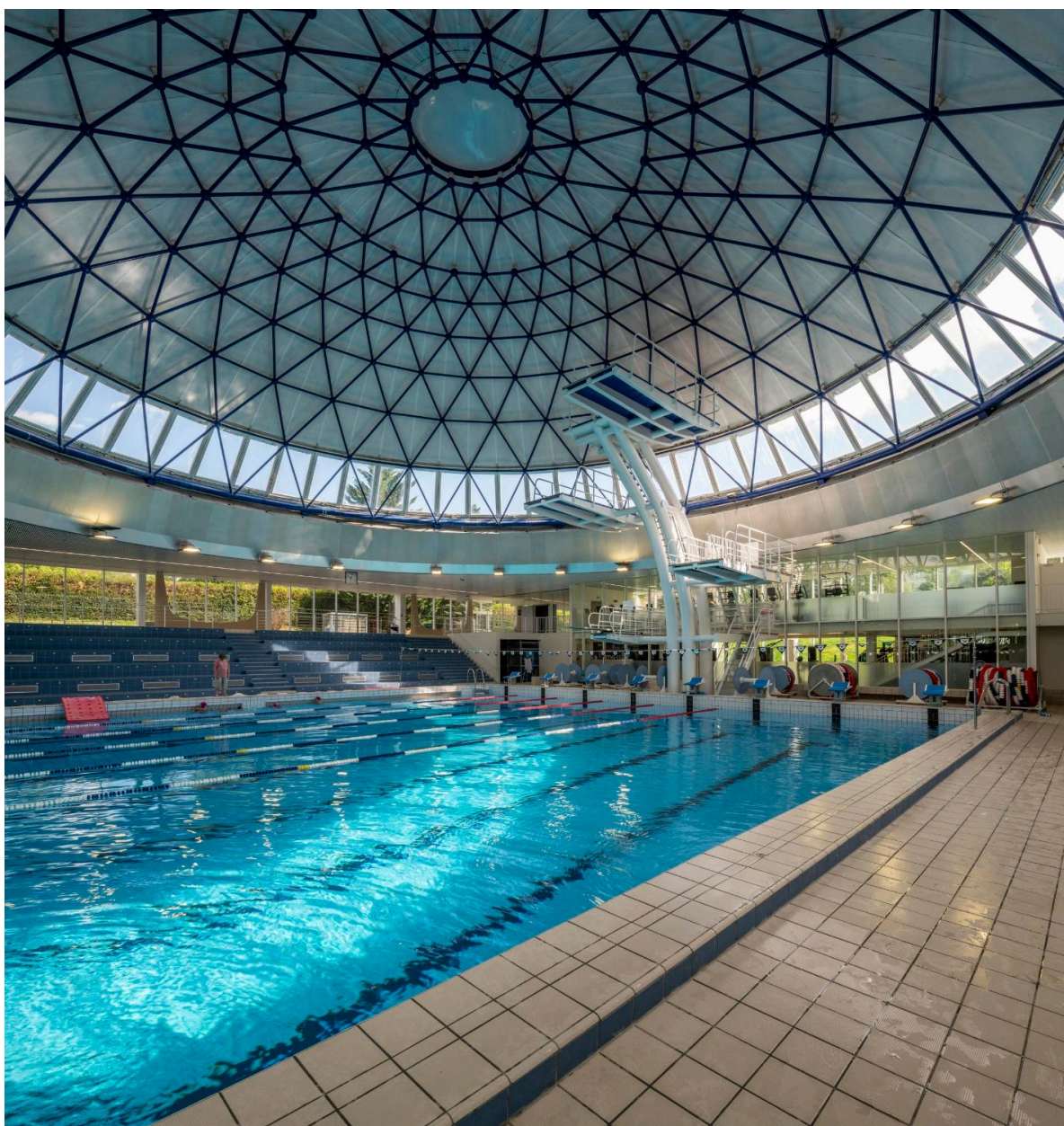
Bassin olympique, plongeoirs et dôme, vue intérieure de l'angle sud-est
