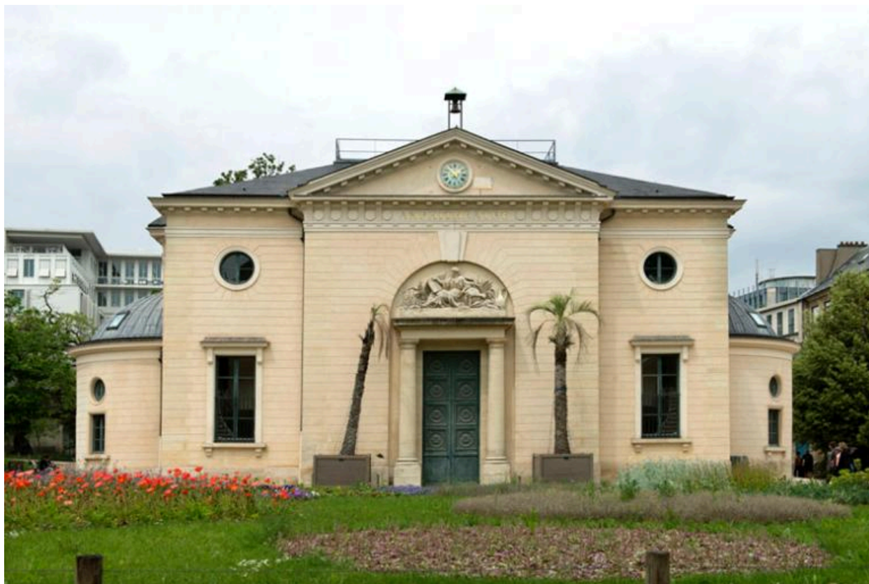
Elévation antérieure, vue générale prise de face.
