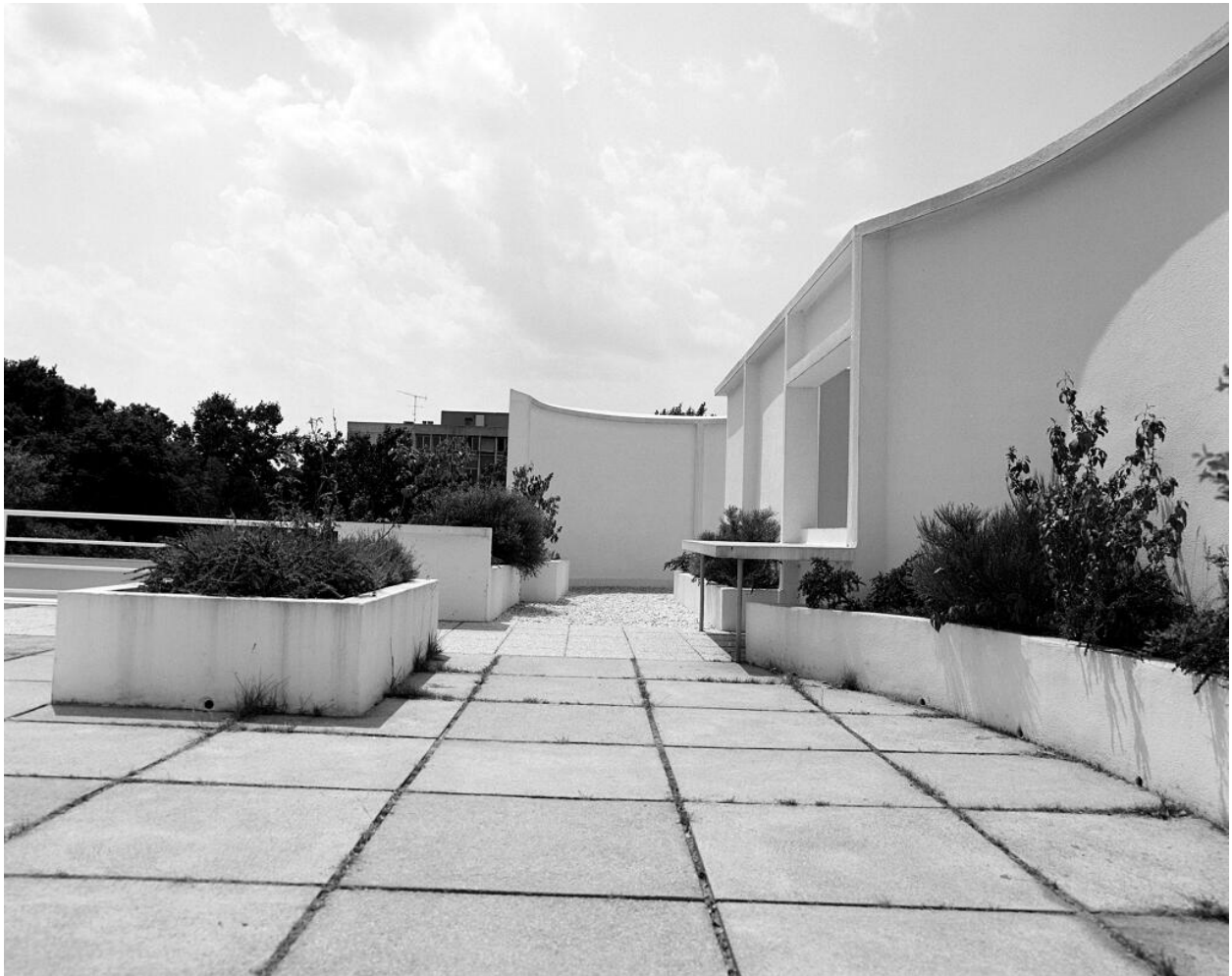
Vue du solarium structuré par des bacs.
