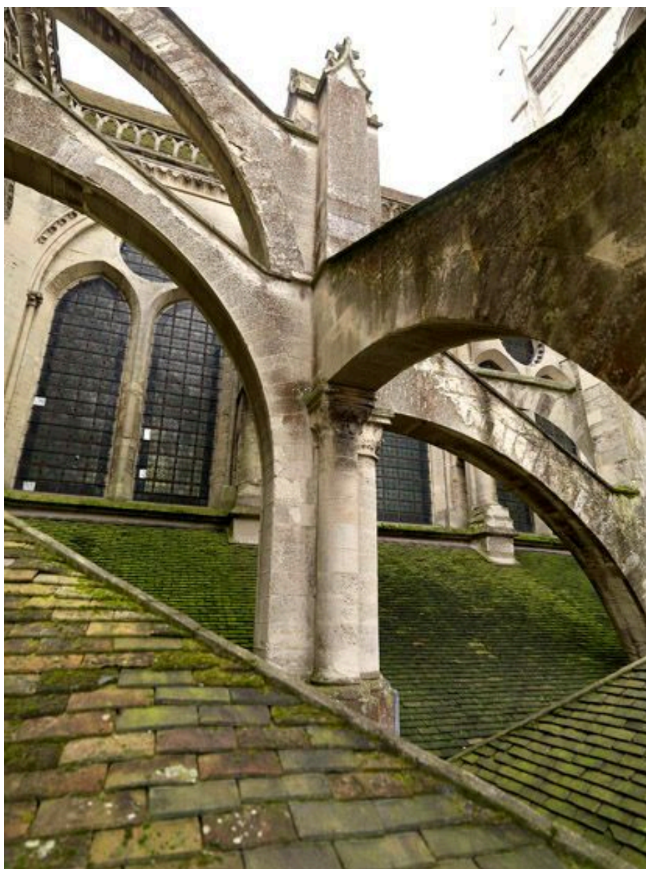
Vue de l'arc-boutant à la jonction de la nef et du bras nord du transept.
