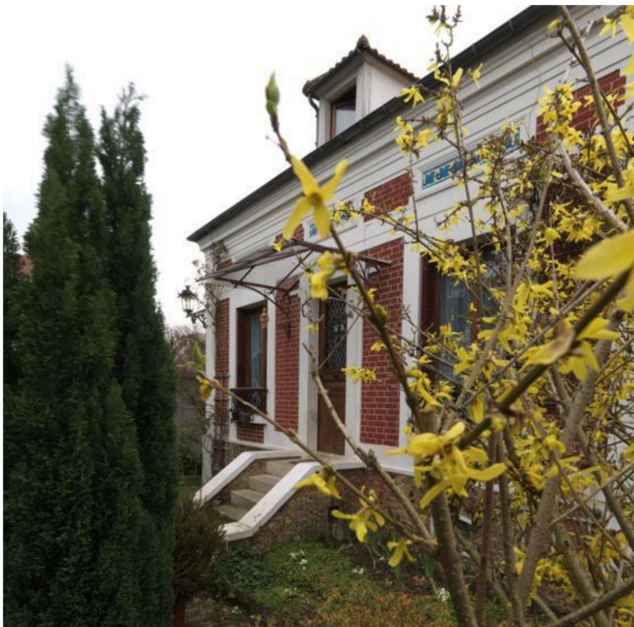
Vue d'ensemble de la façade.
