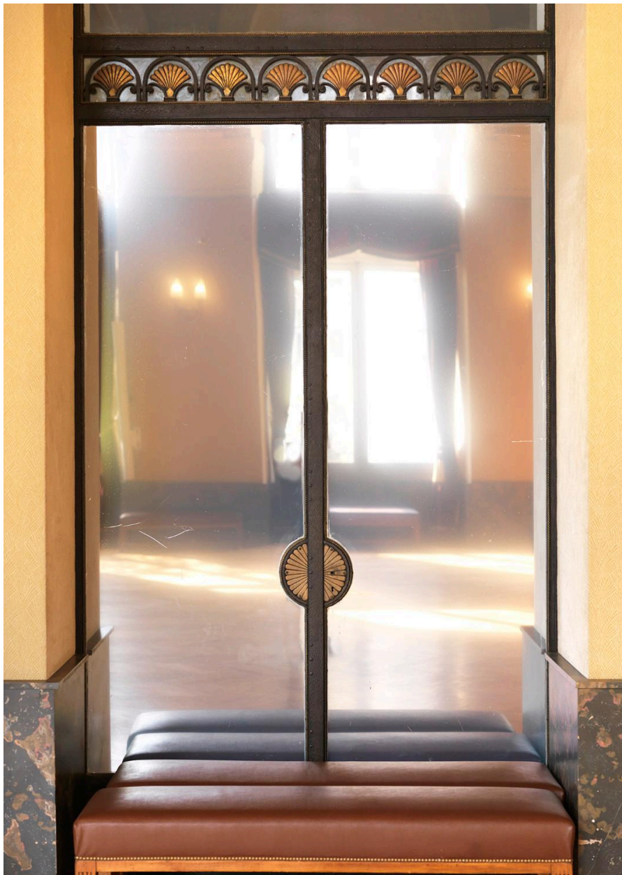
Ferronnerie et vitrage d'une des baies donnant sur le couloir d'accès à la salle, Szabo
