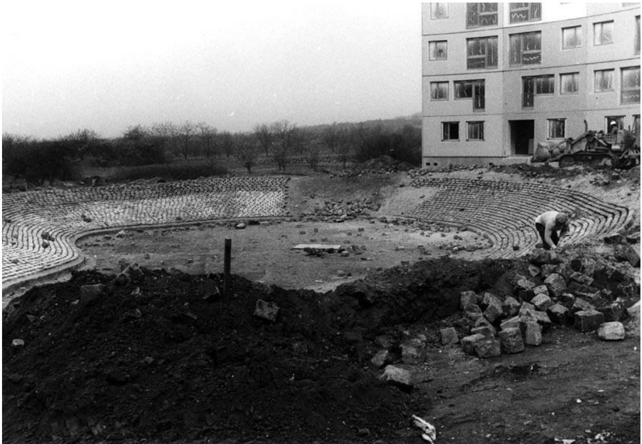
La Noé. Photographie du chantier prise le 17 avril 1973, au niveau de la future place du Bestiaire. Mise en place des pavés de l'enclos destiné à accueillir sur une étendue de sable, le serpent. (Mairie de Chanteloup-les-Vignes).
