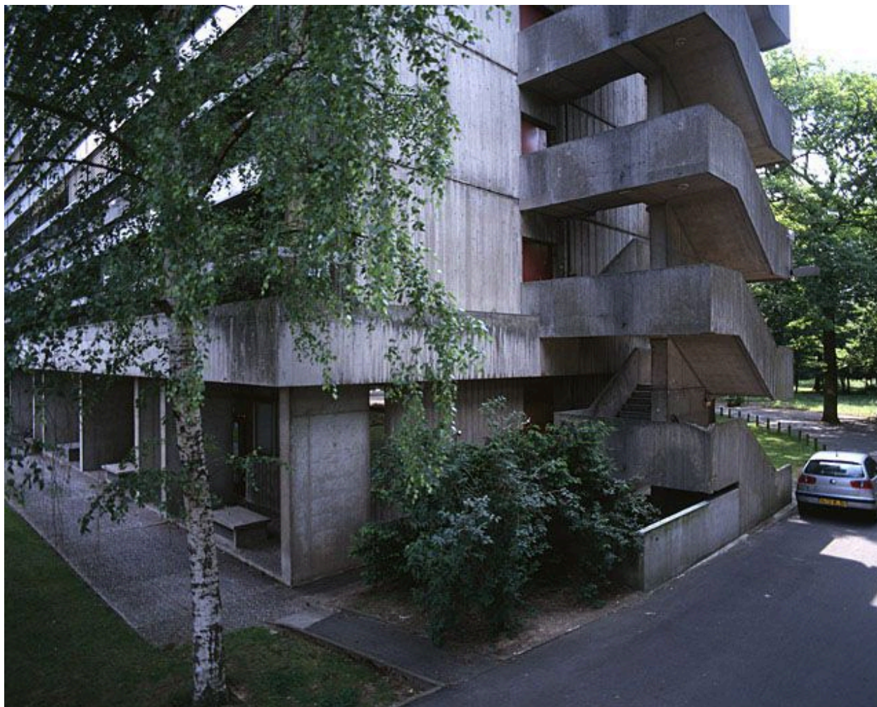
Bâtiment Georges-Brassens : détail du rez-de-chaussée et de l'escalier extérieur.
