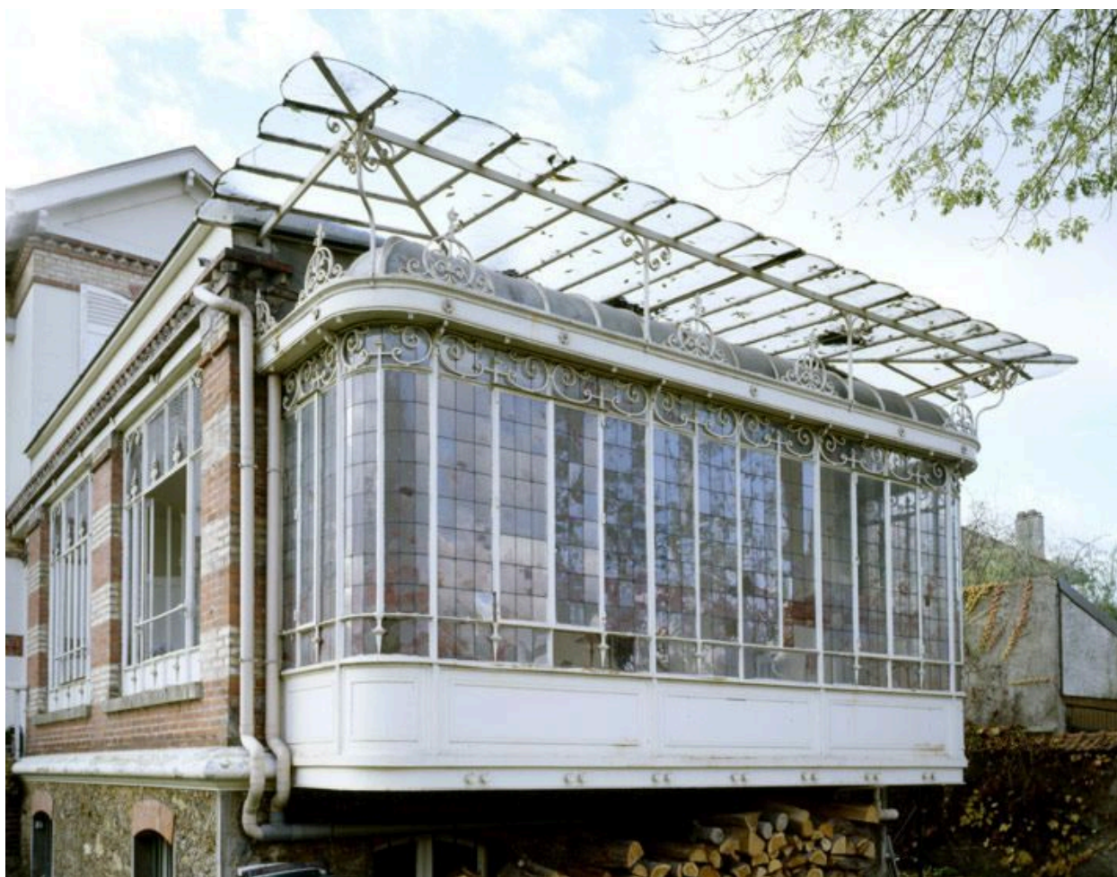
Maison, 24 bis quai Victor Hugo. Détail de l'oriel protégé par une marquise construit en métal et verre du jardin d'hiver. Pivain (verrier)
