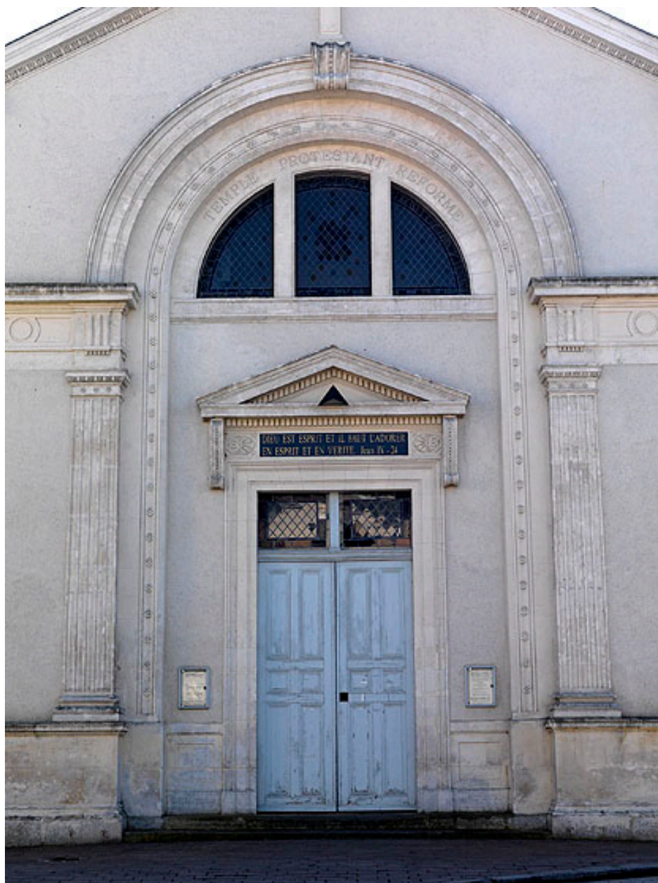
Détail de la façade.
