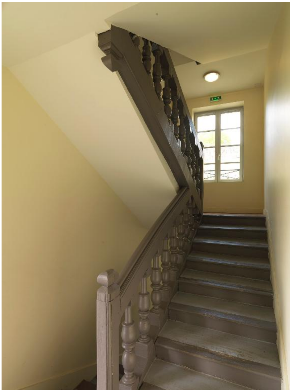
Vue de l'escalier principal, rampe-sur-rampe à balustres de bois.
