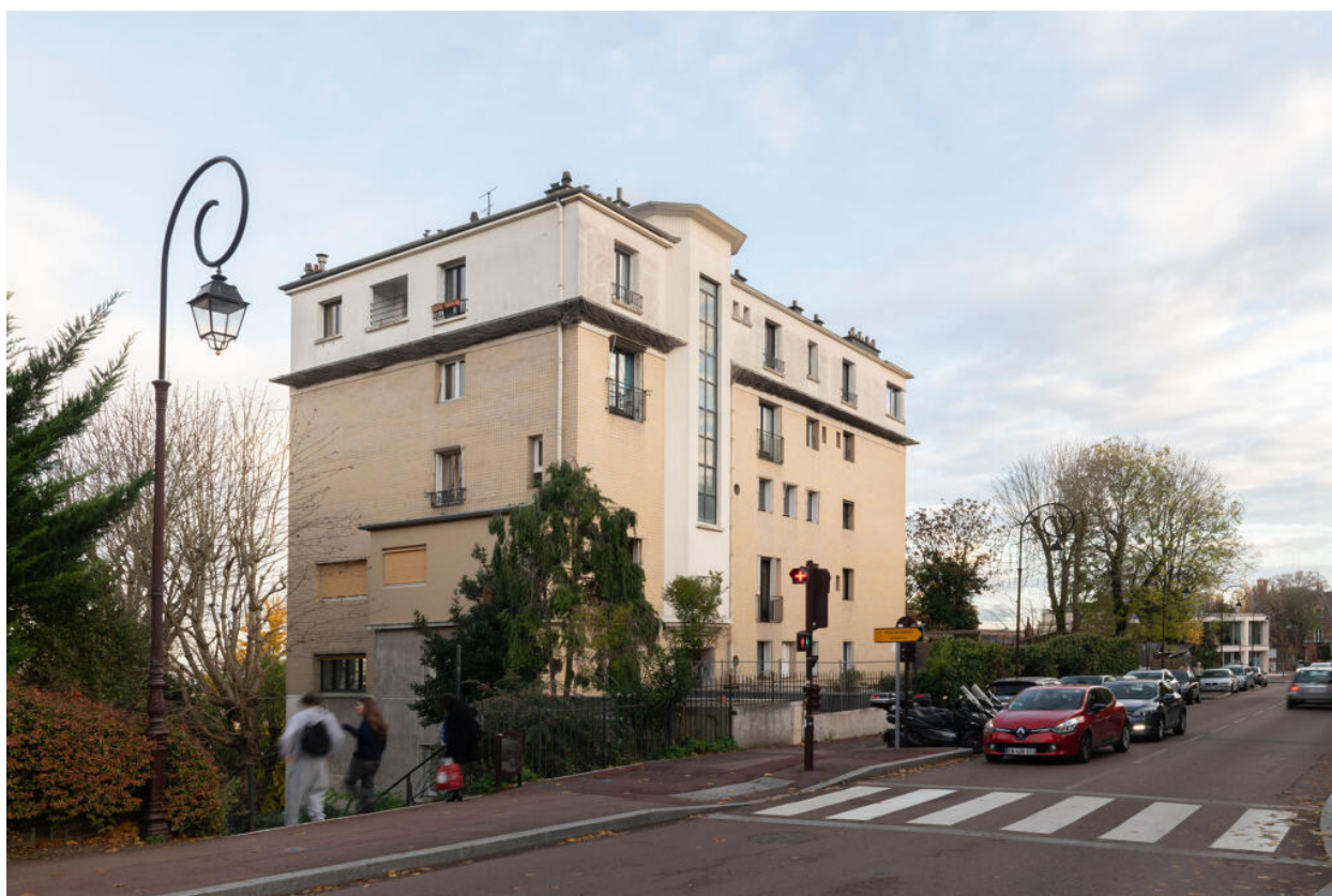
Immeuble, vue depuis le nord-ouest
