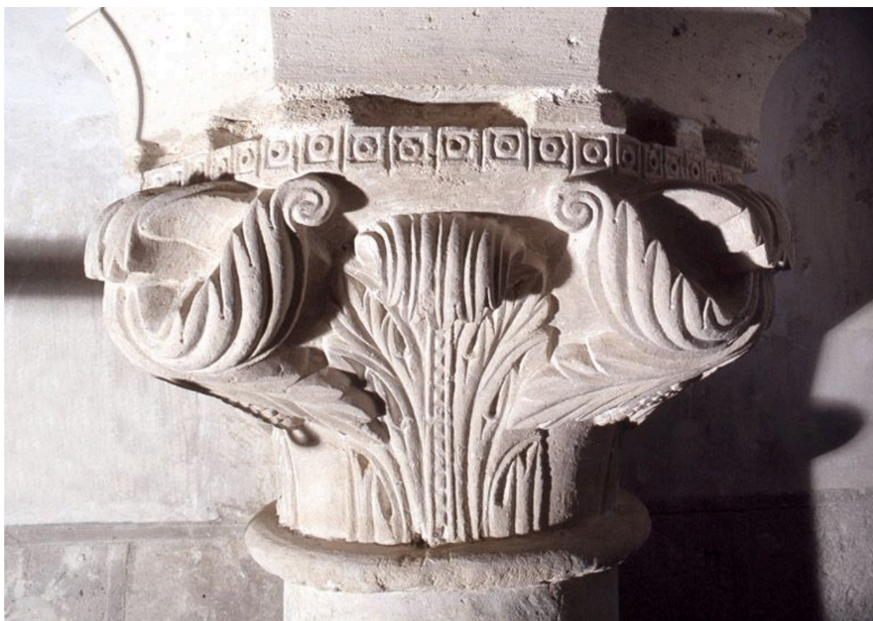
Chapiteau à feuille d'acanthé, vu depuis un échafaudage en 2005 (vue en couleurs).
