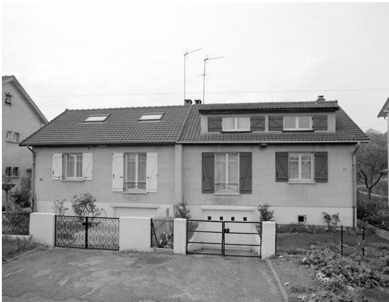
Vue d'ensemble d'un pavillon double de type A, en rez-de-chaussée situé 37-39, avenue du 18 Avril.
