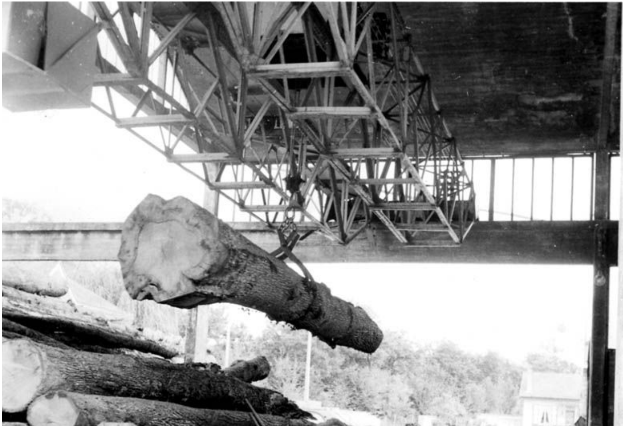
Vue intérieure de la scierie, pont-roulant transportant les grumes. Photographie. (Collection particulière)
