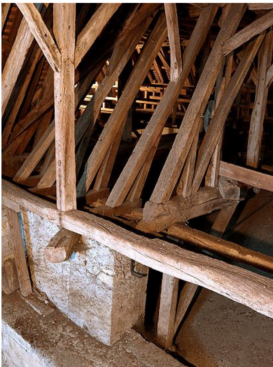
Détail de la charpente du transept.
