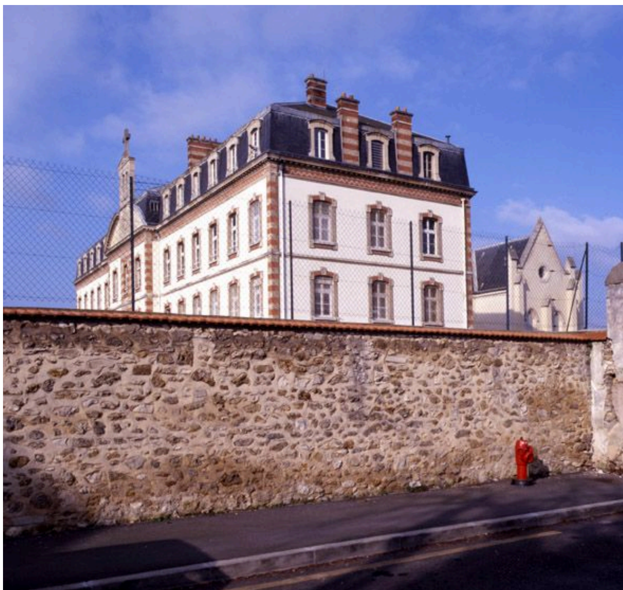
Vue du bâtiment du XIXe siècle, depuis la rue de Chaage.
