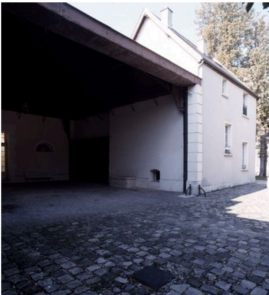
Ancien salon de jardin, accolé à la façade ouest des dépendances, et autrefois vitré.
