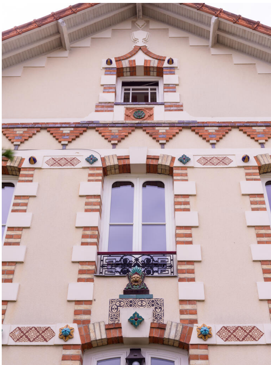
Vue de la façade nord, détail de l'ordonnancement.
