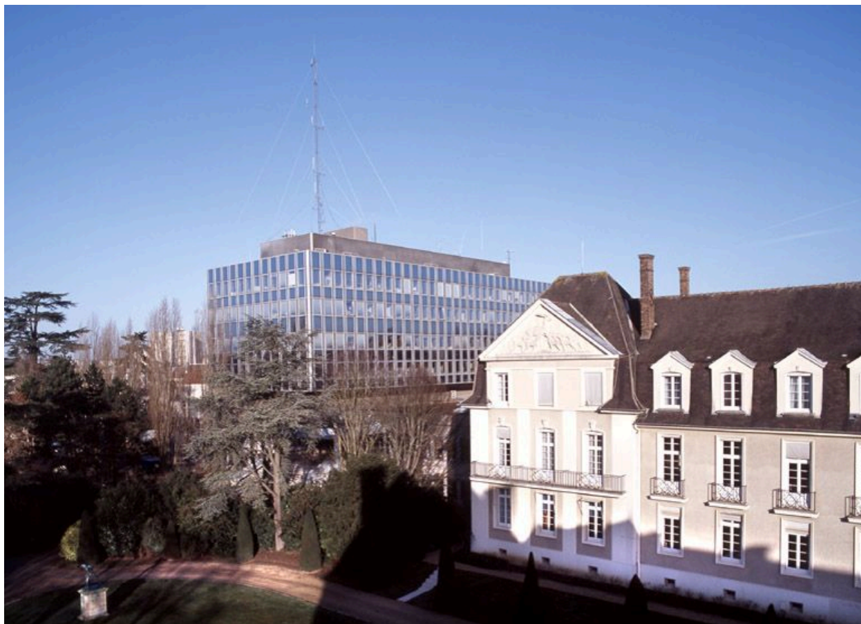
Vue générale des bâtiments au nord de l'hôtel de la préfecture.
