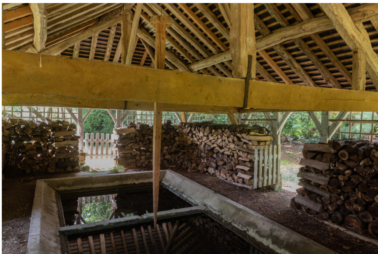
L'intérieur du lavoir séchoir.
