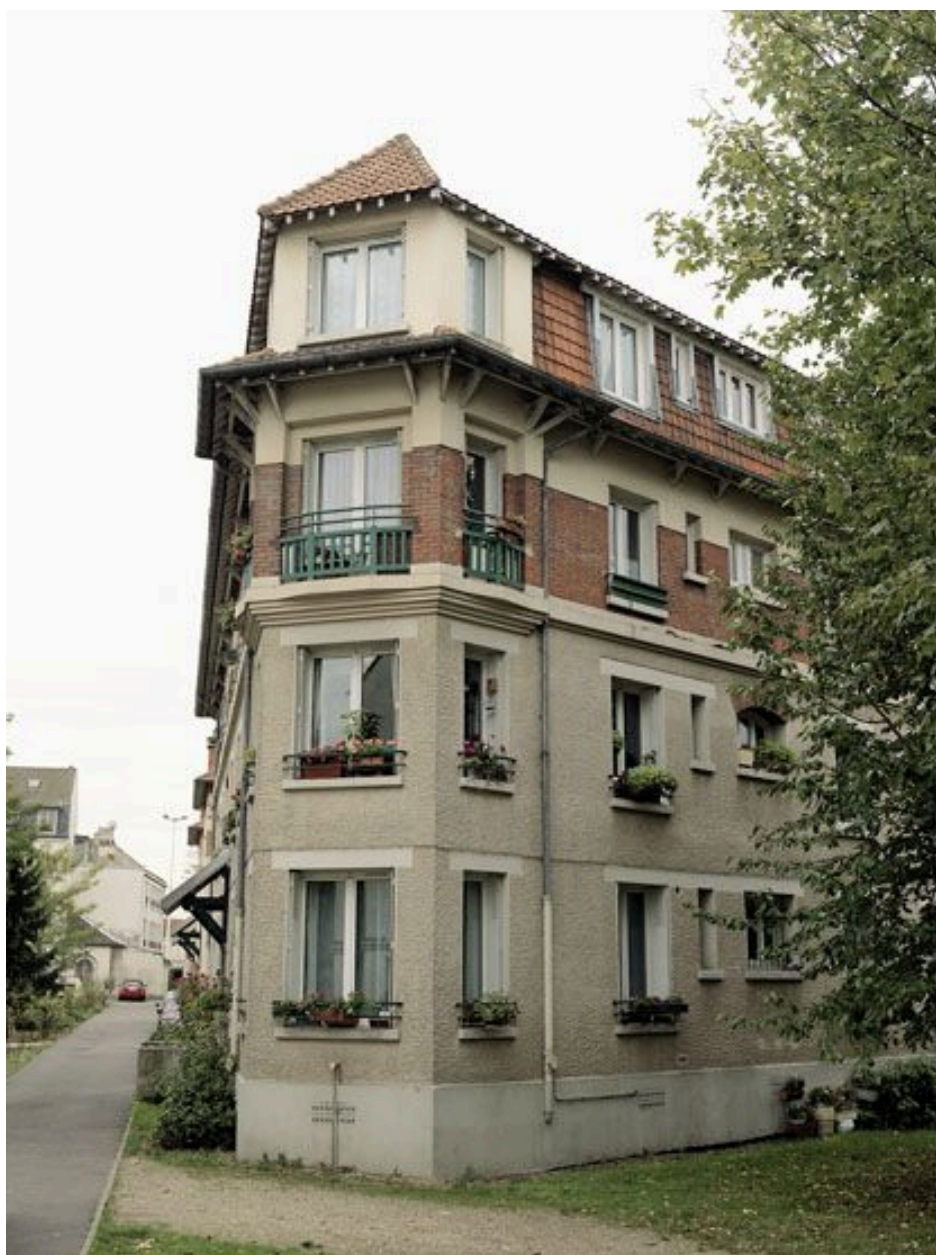
Logements collectifs, rue Vassou.
