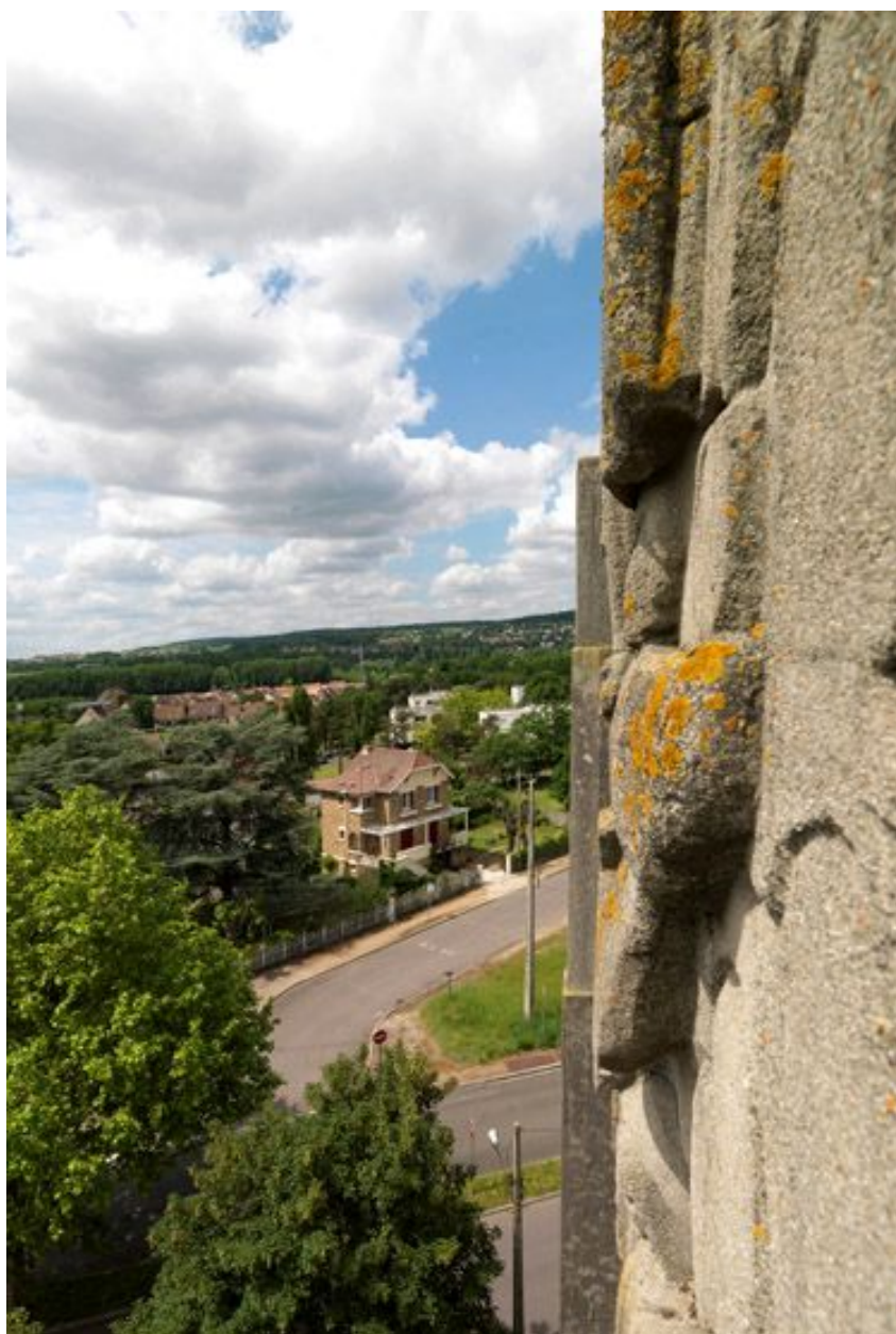
Vue depuis le sommet de l'église.
