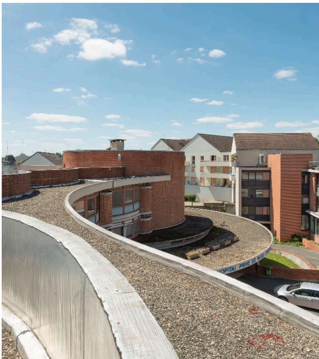
Vue de la façade principale depuis le toit-terrasse.
