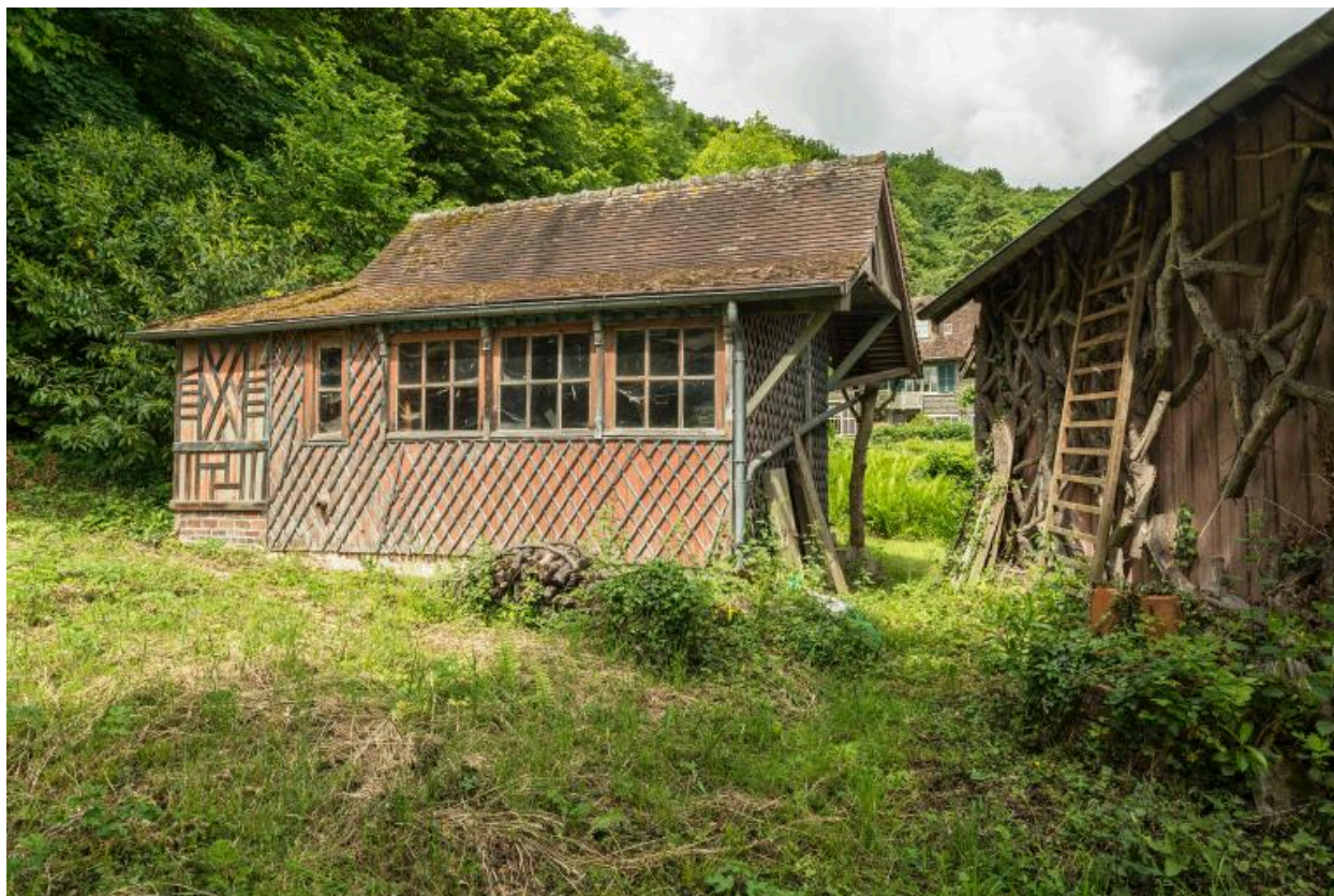
Vue des façades arrières des ateliers (3)
