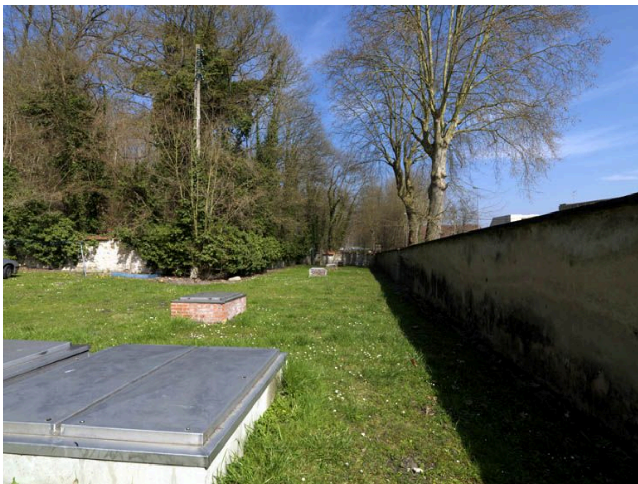
Puits d'accès au captage.
