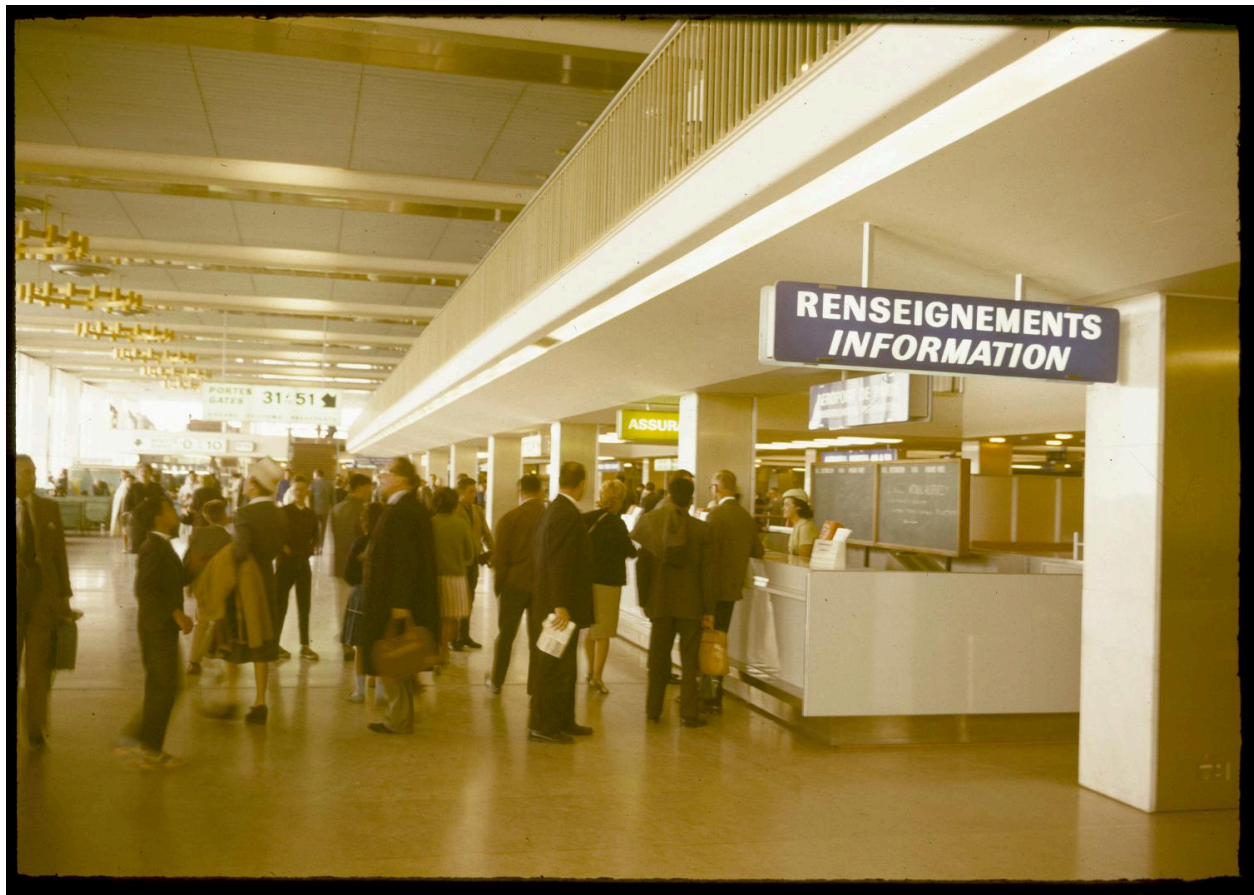
1961, bureau des renseignements dans la Galerie marchande, 1er étage.
