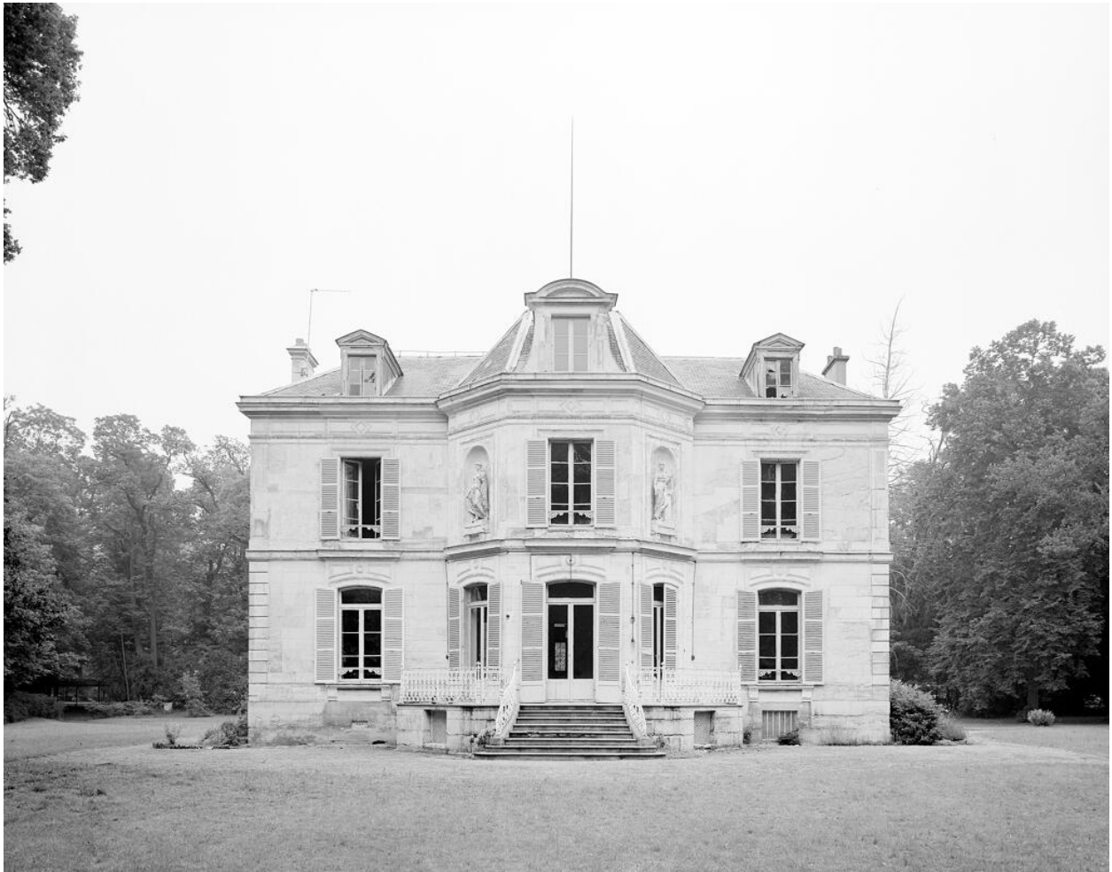
Façade postérieure sur jardin.
