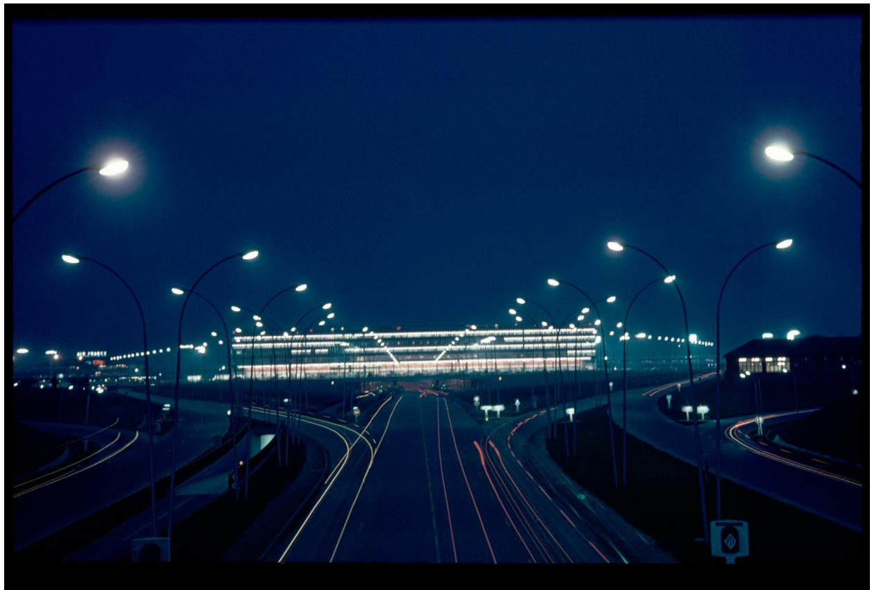
1961, les Installations terminales vues depuis le nord.
