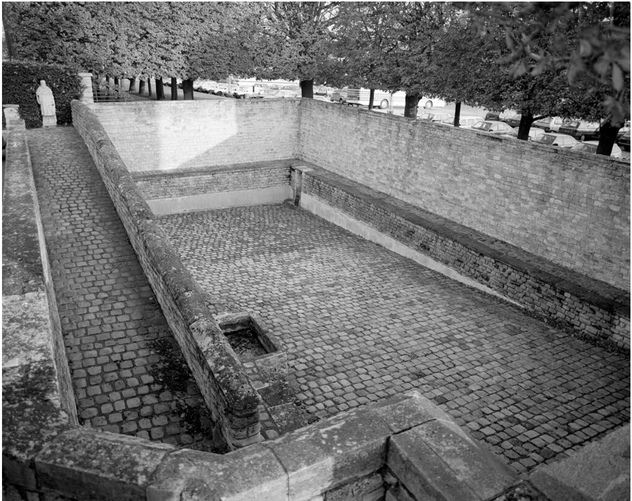
Communs. Grand abreuvoir réalisé vers 1685 pour Colbert de Seignelay. Château de Sceaux
