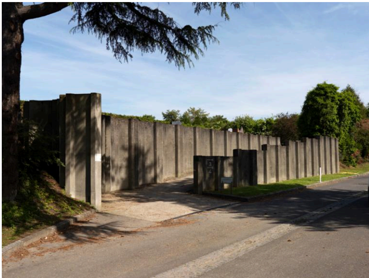
Autre vue d'une rampe d'accès à une aire d'inhumation.
