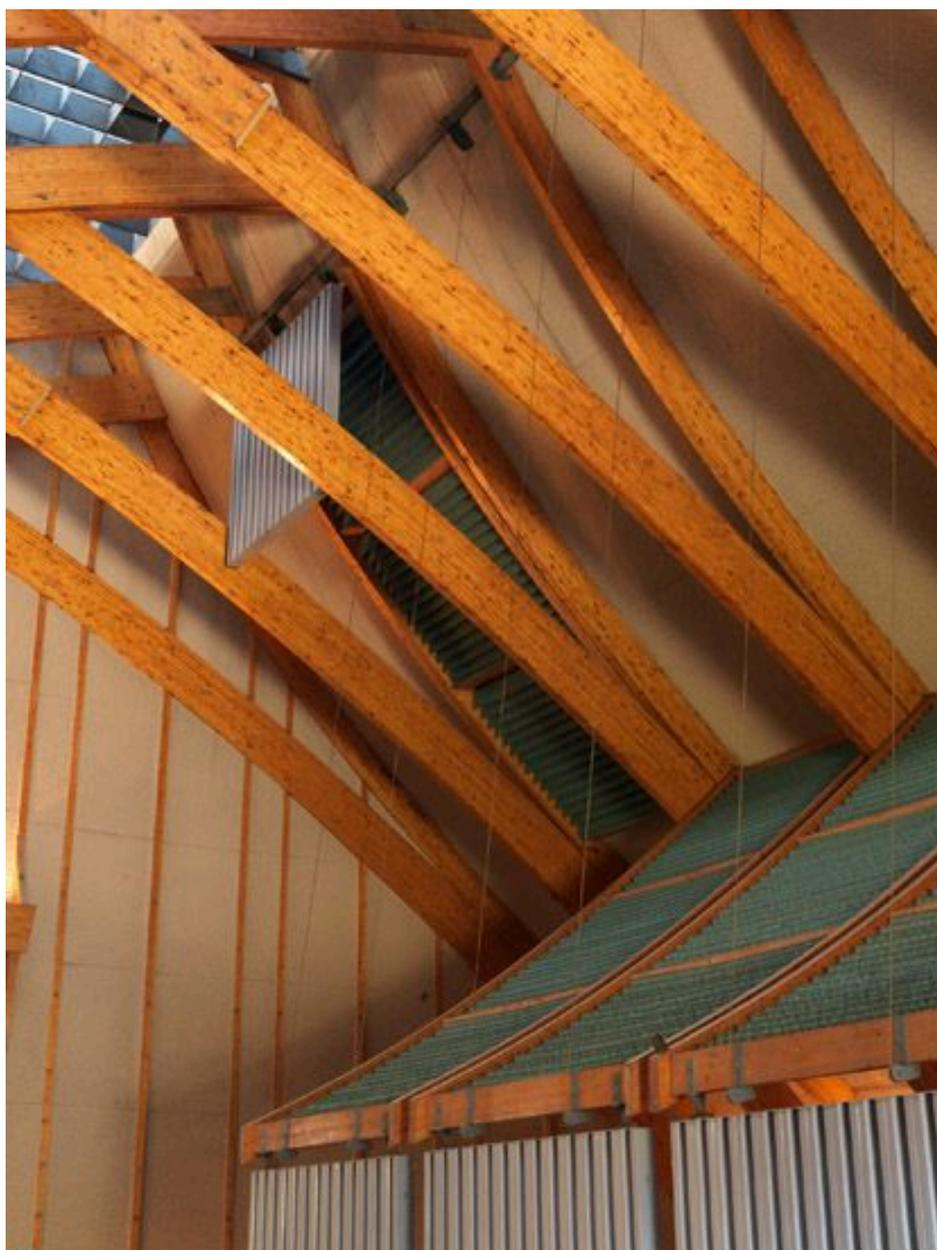
Détail de la charpente en bois lamellé-collé et du système de cloisonnement mobile. L'un des éléments est resté en position haute, tandis que les autres sont abaissés.
