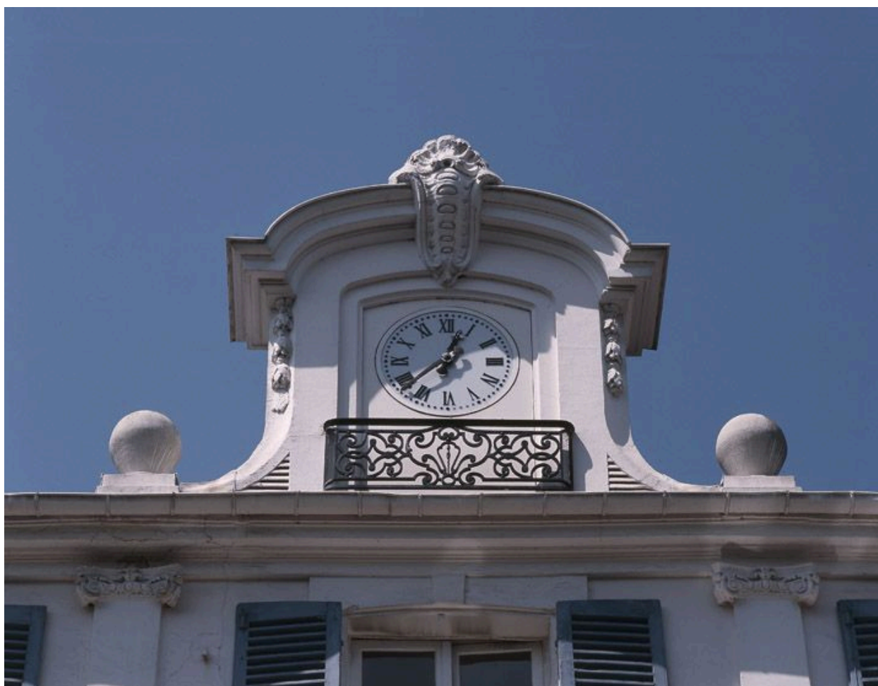
Détail de la lucarne-pignon de la façade principale portant l'horloge.
