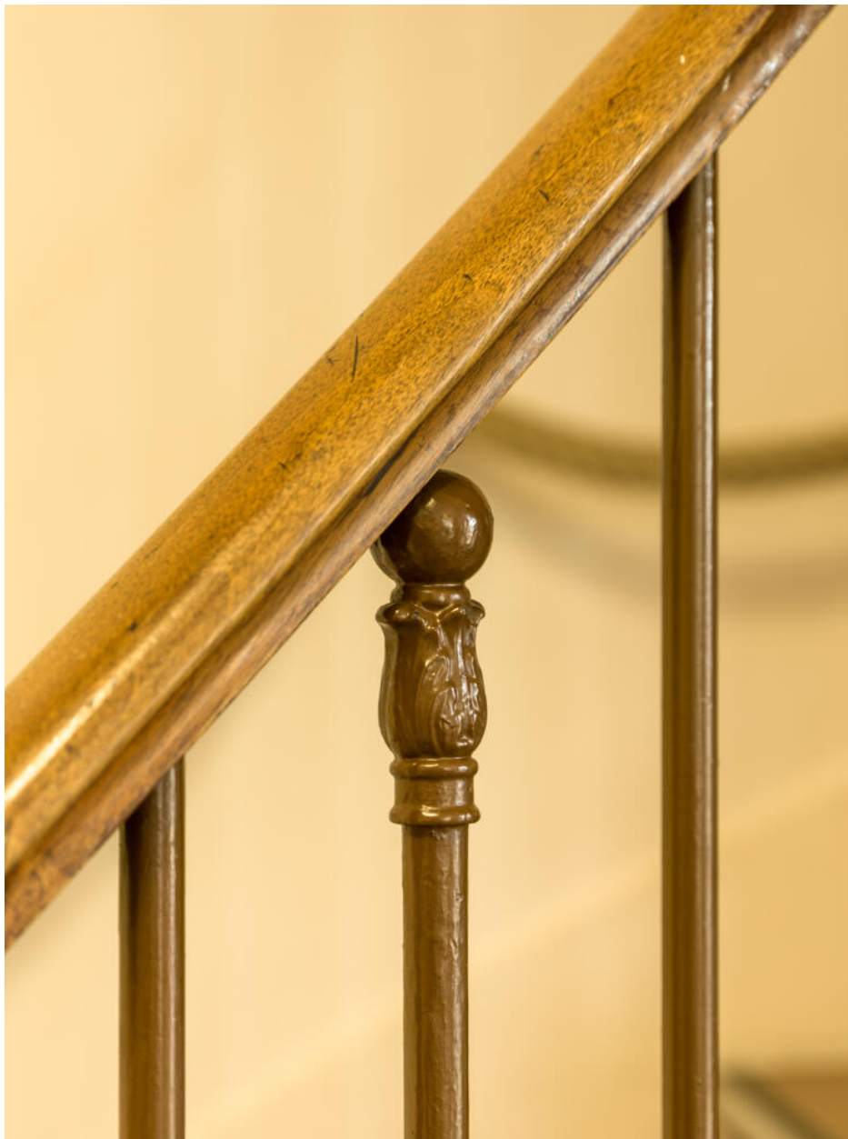
Détail de la rampe.
