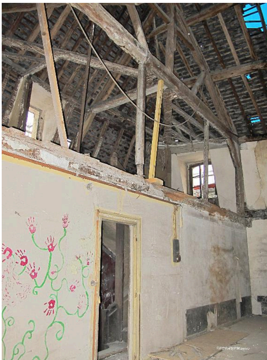
Etat de la charpente avant restauration.
