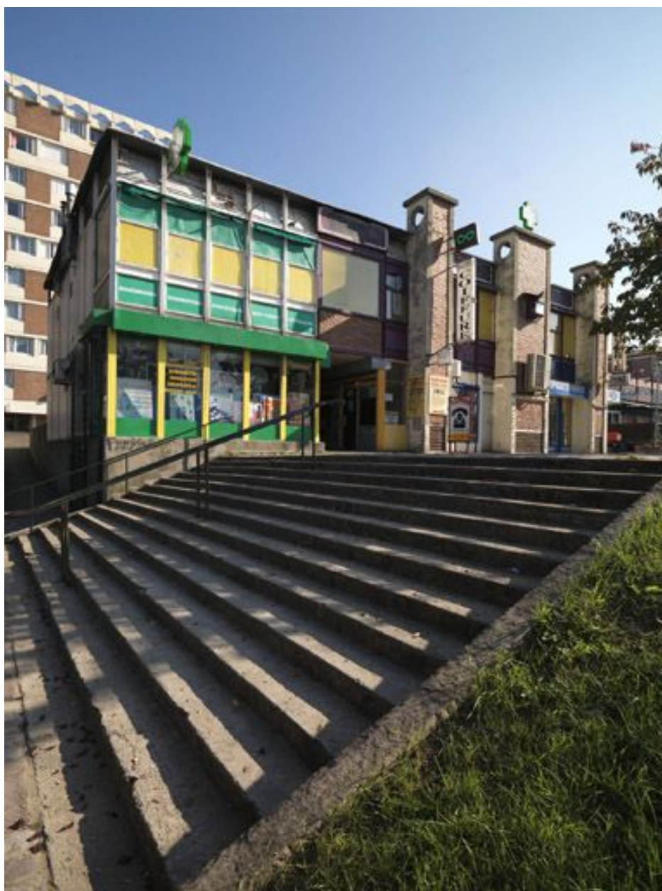
Vue du centre commercial de la Patte d'Oie, côté place du 8 Mai 1945.
