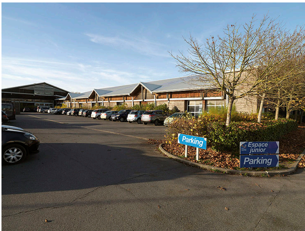
Les gymnases, vus du sud-est.
