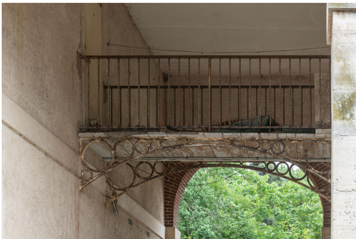
Détail d'un passage dans les communs de l'ancienne maison Arouet.
