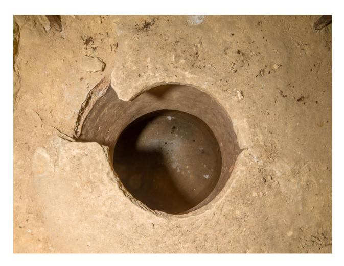
Intérieur d'un silo expérimental de 6 m3 creusé en 1821. Enduit d'un mélange d'huile de lin, de cire d'abeille, d'oxyde de plomb et de brique pilée pour le rendre étanche.
